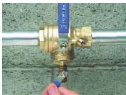
4. Öppna avtappningsventilen
