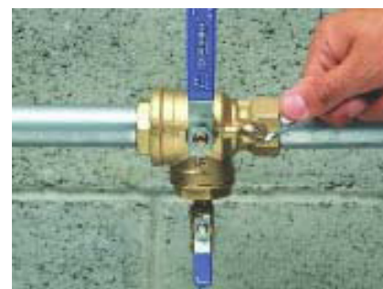
6. Drag åt insexskruven
