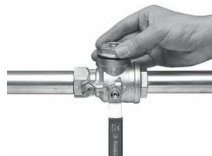
6 Återmontera filtret
