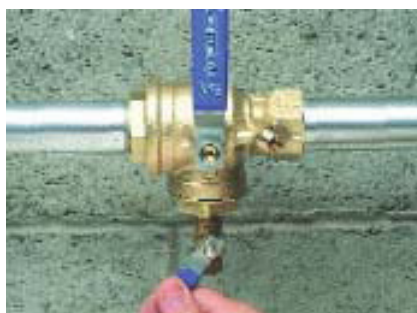
7. Stäng avtappningsventilen
