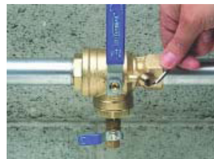
3. Öppna insexskruven ett par varv
